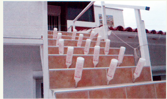
Ejemplo para la aplicación de YaSeco en las cruces de juntas de azulejos, San Isidro
